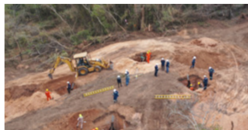
Sitio de construcción- Línea de transmisión
